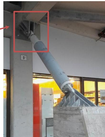
*Nell'immagine un edificio prefabbricato in CA al quale sono stati applicati dei dispositivi viscosi FIP*
