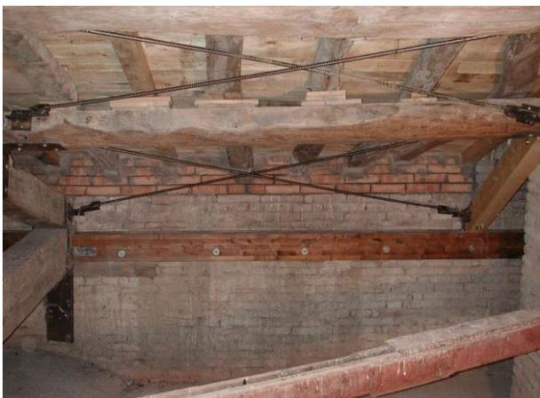
*Rinforzo antisismico della copertura in legno, tramite elementi lignei di collegamento alle murature portanti e controventamento della falda*
