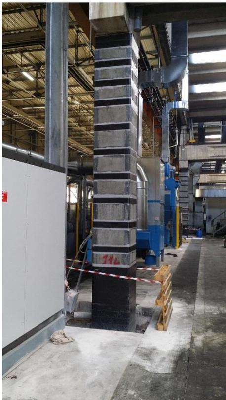
Opere di rinforzo di un pilastro in C.A. tramite fibre di carbonio
