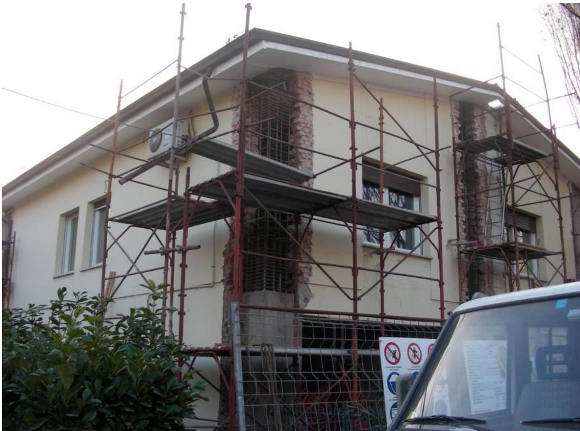
*Lavori di miglioramento sismico: inserimento strutture CA*
