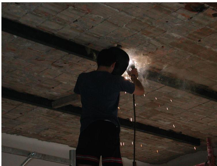
*Miglioramento sismico di una scuola: Rinforzo di un solaio*
