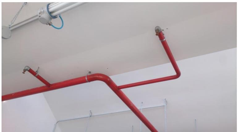
Progetto impianto estinguente a diluvio: linee e ugelli a soffitto.
