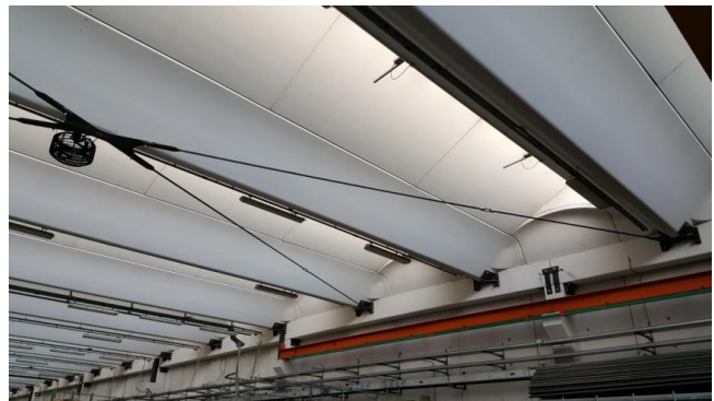
FBN – Novellara: Miglioramento sismico di struttura esistente prefabbricata: particolare controventamento copertura
