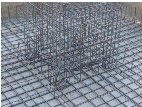
Particolare Armature Plinto a Bicchieri – Capannone prefabbricato
