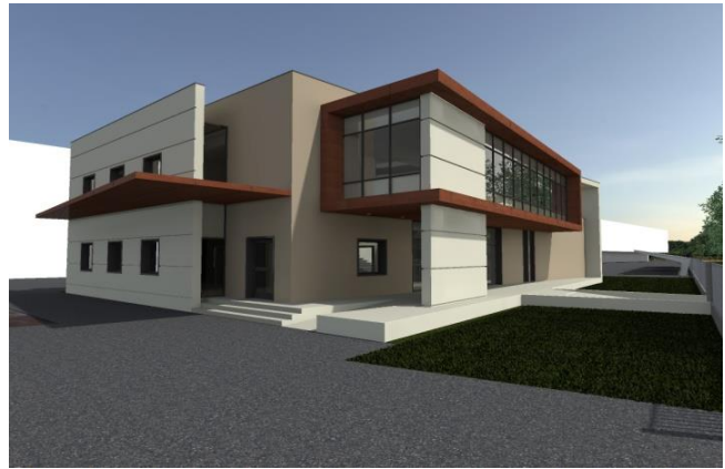
Stabimento produttivo PROFILTUBI SpA – Reggio (RE) – Nuova Palazzina Uffici a Struttura metallica antisismica
