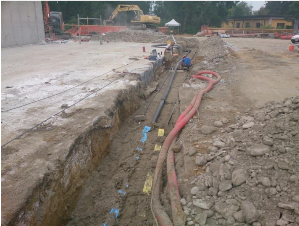
Progetto impianto estinguente a diluvio: realizzazione linea antincendio.
