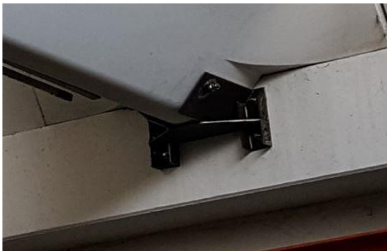
Piastra di vincolo trave-tegolo per attacco controventi di falda
