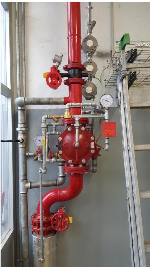
Progetto impianto estinguente a diluvio: impianto pressurizzazione.
