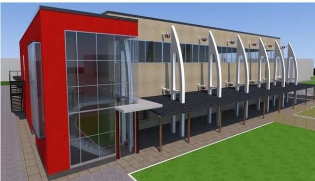
Centro Sociale Rio Saliceto: Struttura prefabbricata esistente soggetta a miglioramento sismico tramite strutture metalliche dissipative
