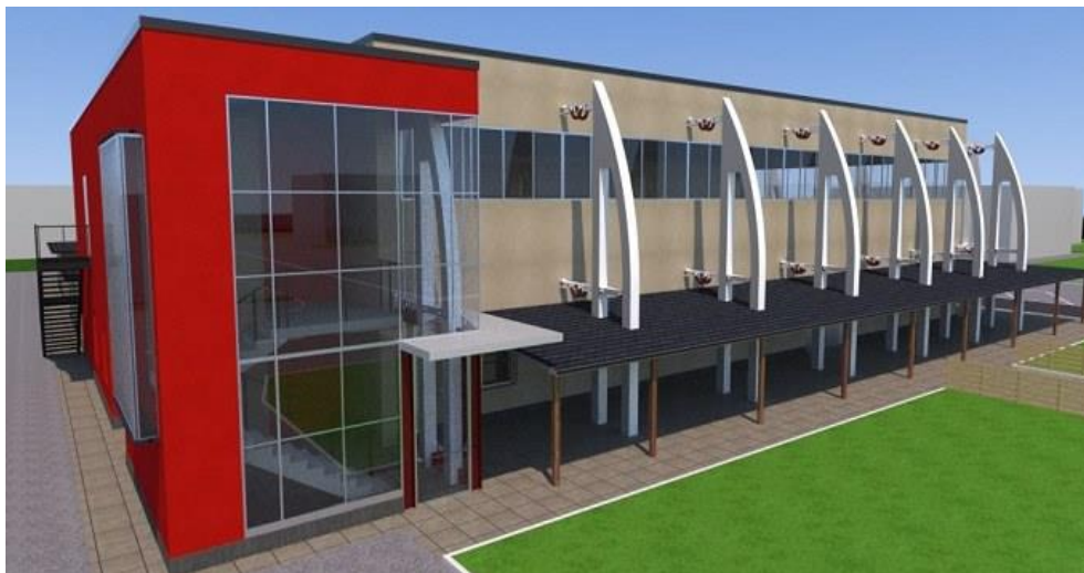
Centro Sociale Rio Saliceto: Struttura prefabbricata esistente soggetta a miglioramento sismico tramite strutture metalliche
