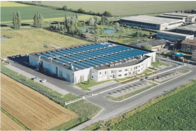
Stabimento produttivo Stromab – Campagnola Emilia (RE) – Struttura antisismica prefabbrica con palazzina in opera
