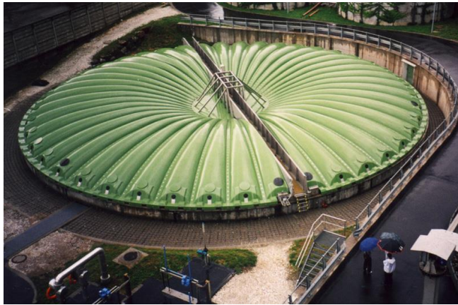
Copertura vasca di un Depuratore – Struttura in compositi
