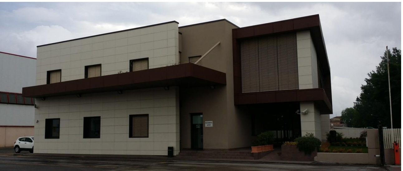
Stabilimento produttivo PROFILTUBI SPA – Reggiolo (RE) – Nuova Palazzina Uffici realizzata
