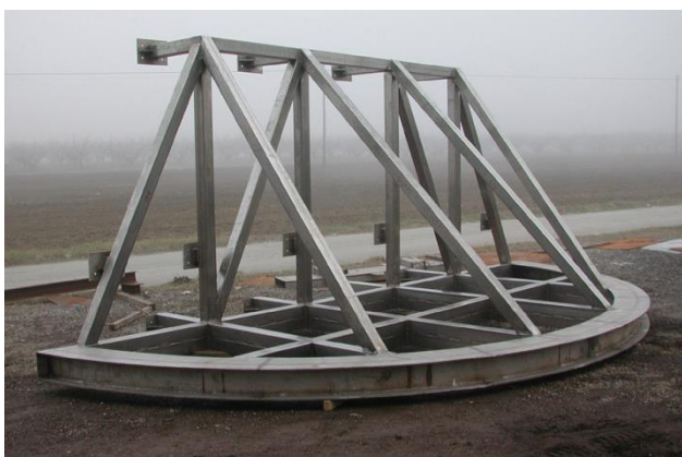
Struttura metallica ad anello – Copertura in PRFV \varnothing 32 m
