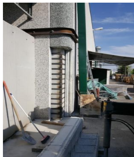
Rinforzo sismico di un pilastro d'angolo prefabbricato
