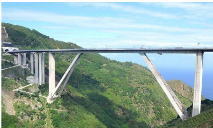
Fig. 2 - Viadotto Sfalassà, Silvano Zorzi
