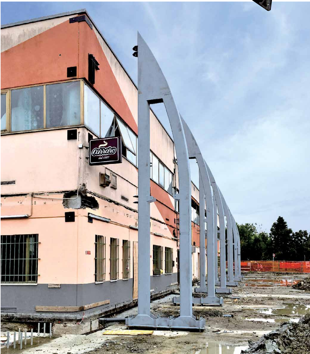
Figura 25 Montaggio strutture metalliche.
