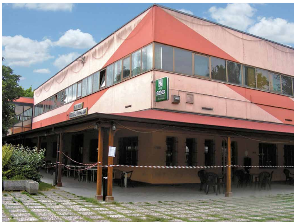
Figura 1 Edificio dichiarato inagibile a seguito del sisma 2012.
