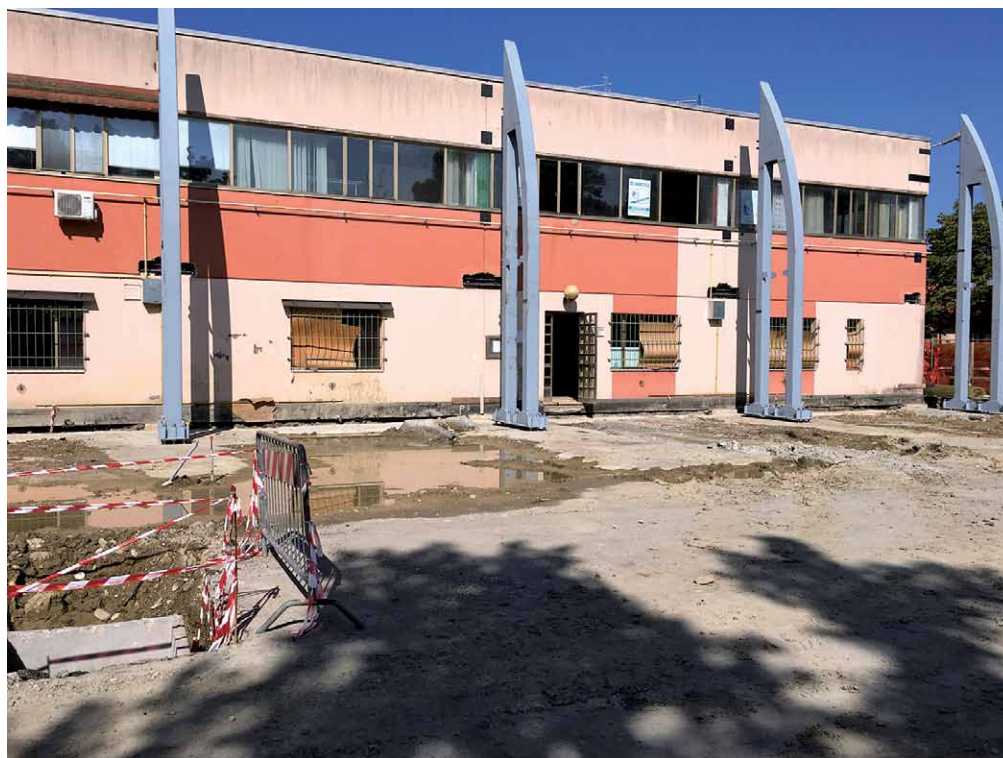
Figura 26 Montaggio strutture metalliche.
