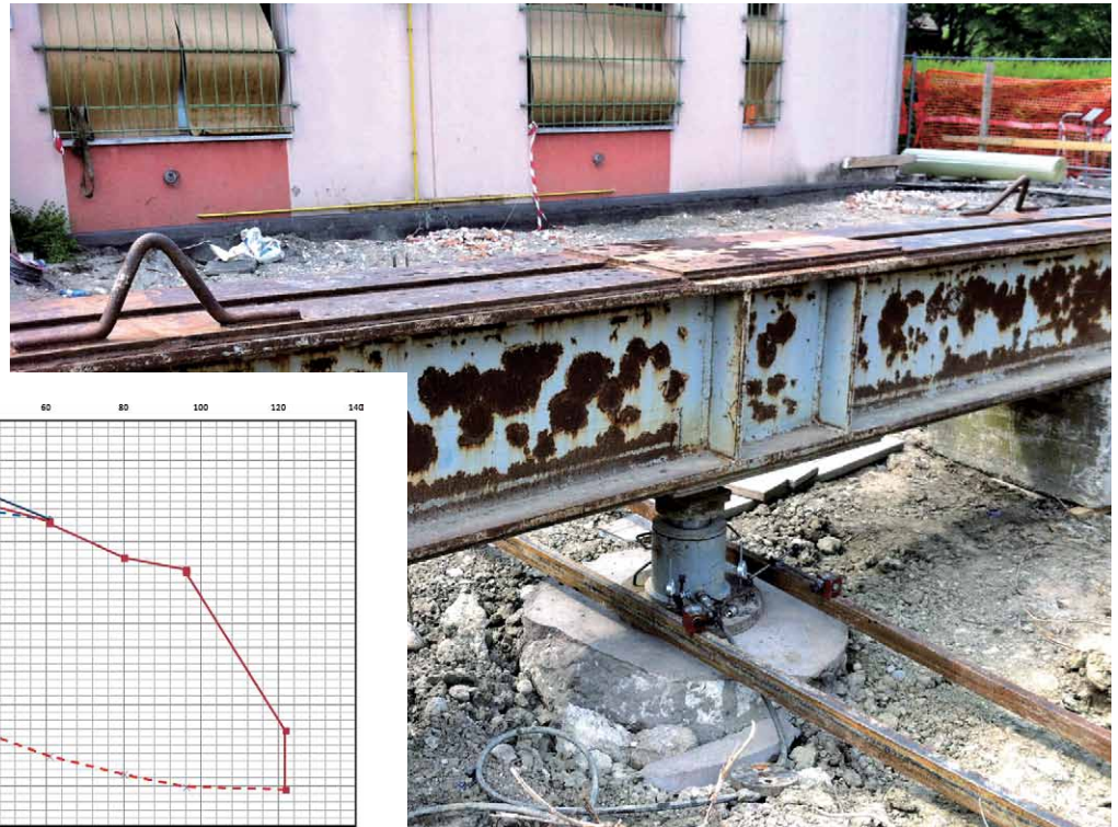
Figura 22 Prova di carico su "palo di prova", fino al 200% del carico di esercizio (120 ton).
