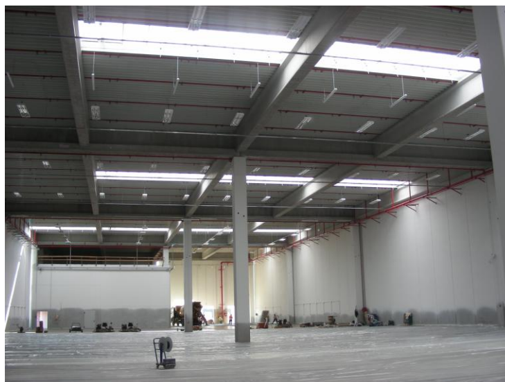
Struttura prefabbricata con copertura in pannelli sandwich
