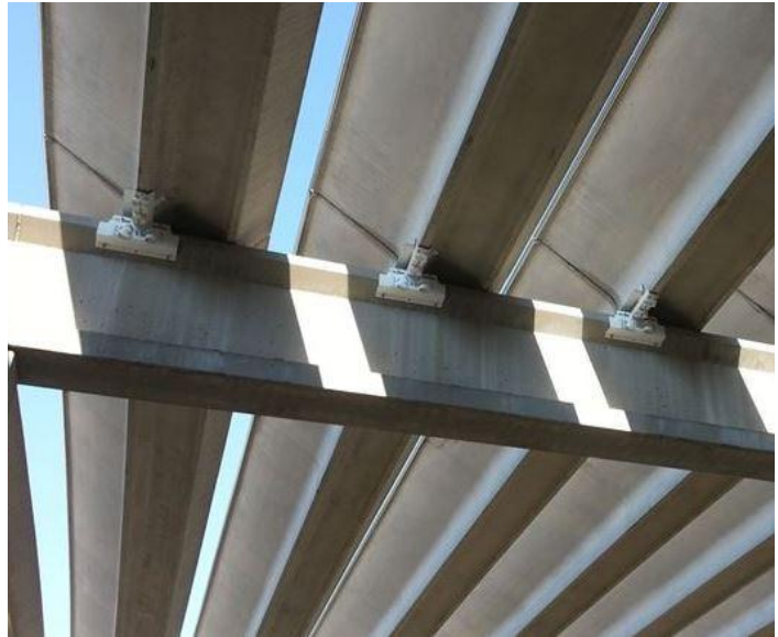
Esempio di dispositivo applicato agli appoggi dei tegoli, con vincolo a carrello.
