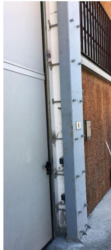
Pilastro in C.A. rinforzato e confinato tramite fibre di carbonio o con lamiere incollate Si ottiene: un aumento del momento ultimo, del taglio ultimo, della resistenza ciclica e della duttilità
