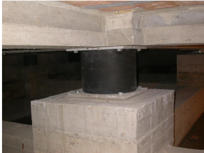
Isolatore elastomerico in fondazione
