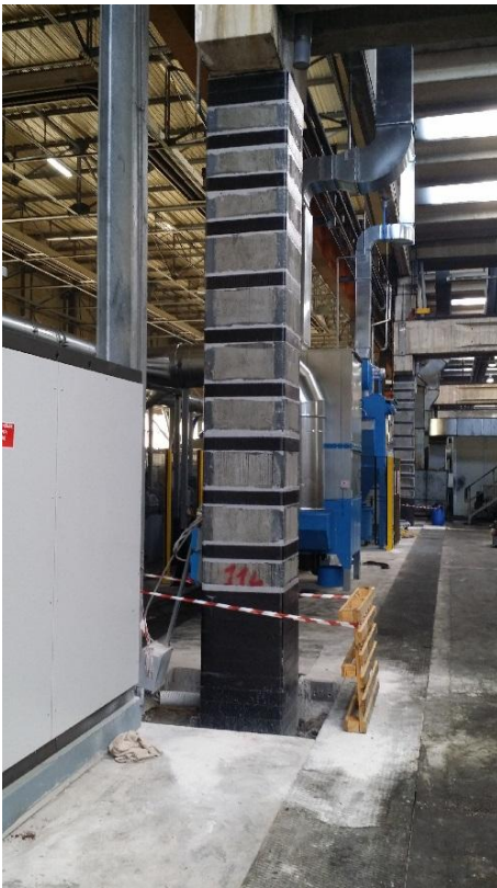
Pilastro in C.A. rinforzato e confinato tramite fibre di carbonio o con lamiere incollate Si ottiene: un aumento del momento ultimo, del taglio ultimo, della resistenza ciclica e della duttilità
