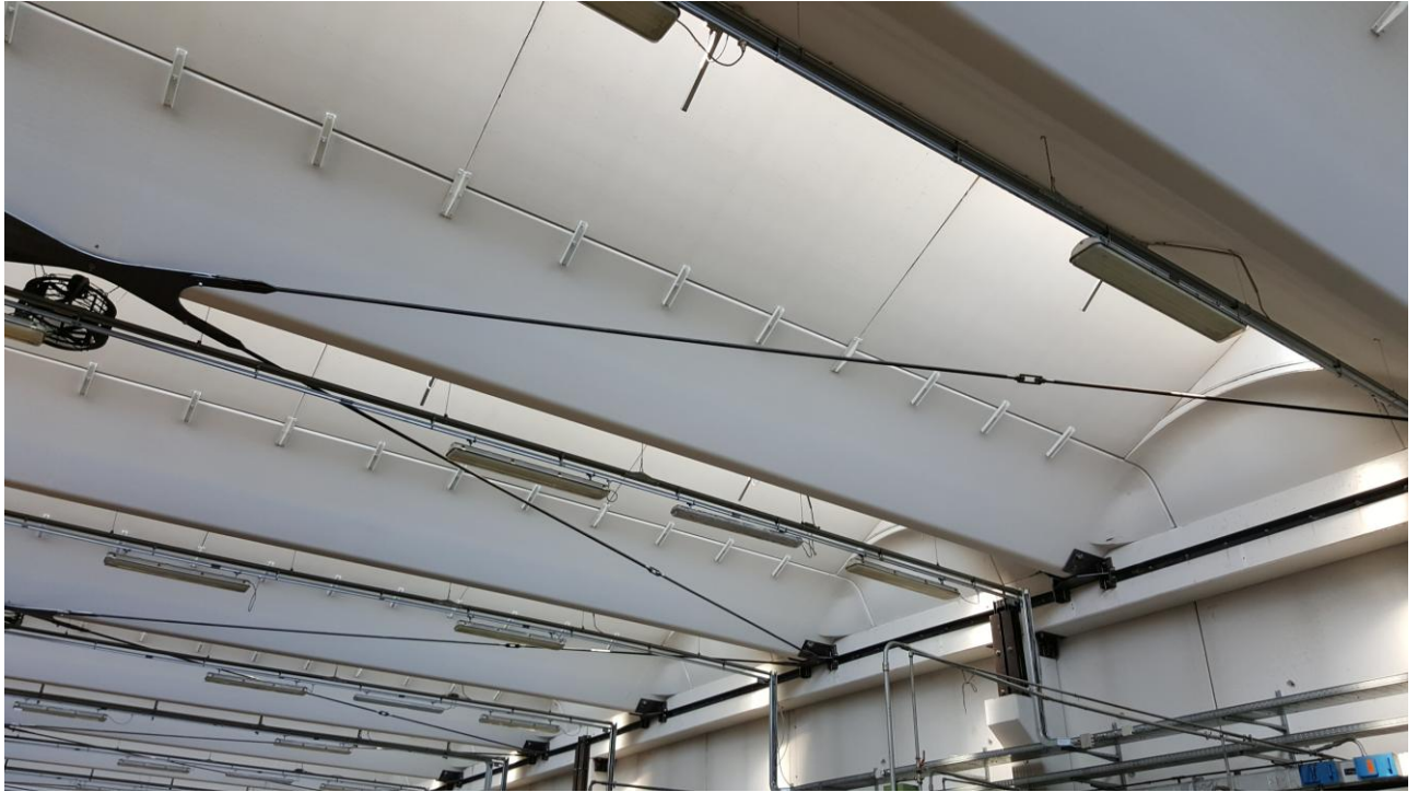
Controventamento di copertura in tegoli precompressi e sheds
