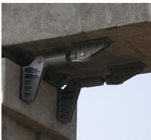
Collegamento trave-pilastro: appoggio scorrevole con dissipatore
